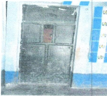
Foto 7: Mantenimiento a puertas de metal
